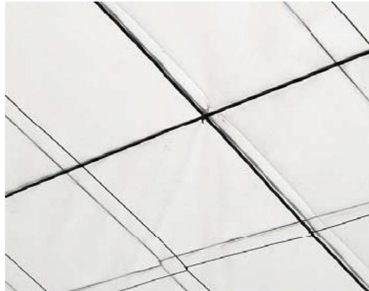
Estructura horizontal (plana) constituida por **dos mallas de alambre galvanizado superpuestas**, tejidas manualmente de forma simultánea a la construcción del invernadero. **Permiten sostener y sujetar la lámina de plástico** entre ellas
