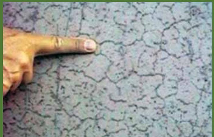
Figura 3. Expansion del concreto por los sulfatos
