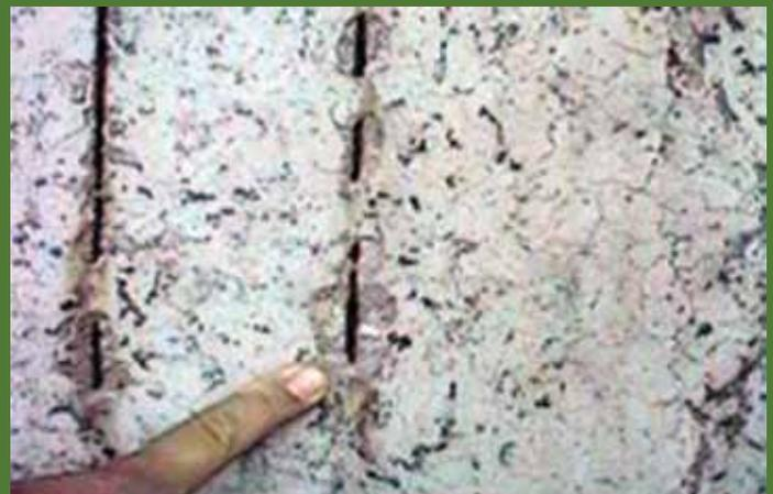
Figura 2. Poco recubrimiento de la armazón de acero, expuesto a la corrosión por los cloruros y concreto fisurado por la expansión de éste por los sulfatos.
