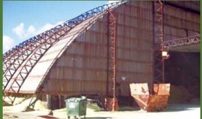
Figura 1. Galpón atacado por la corrosión en todos sus elementos estructurales.
